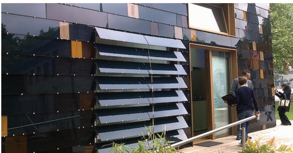
Besuch „Energie Plus Haus“, Essen
